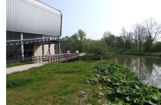
5 Tussen Waterlinieweg Viaduct en Herculesbrug
